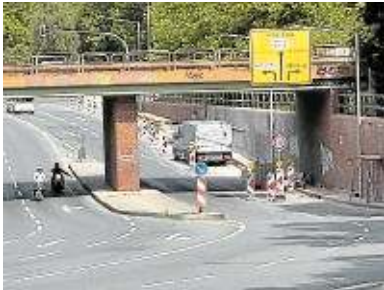
Der Ellerbruchtunnel ist ein wichtiger Verkehrsknotenpunkt in Buxtehude. Foto: Sulzyc
